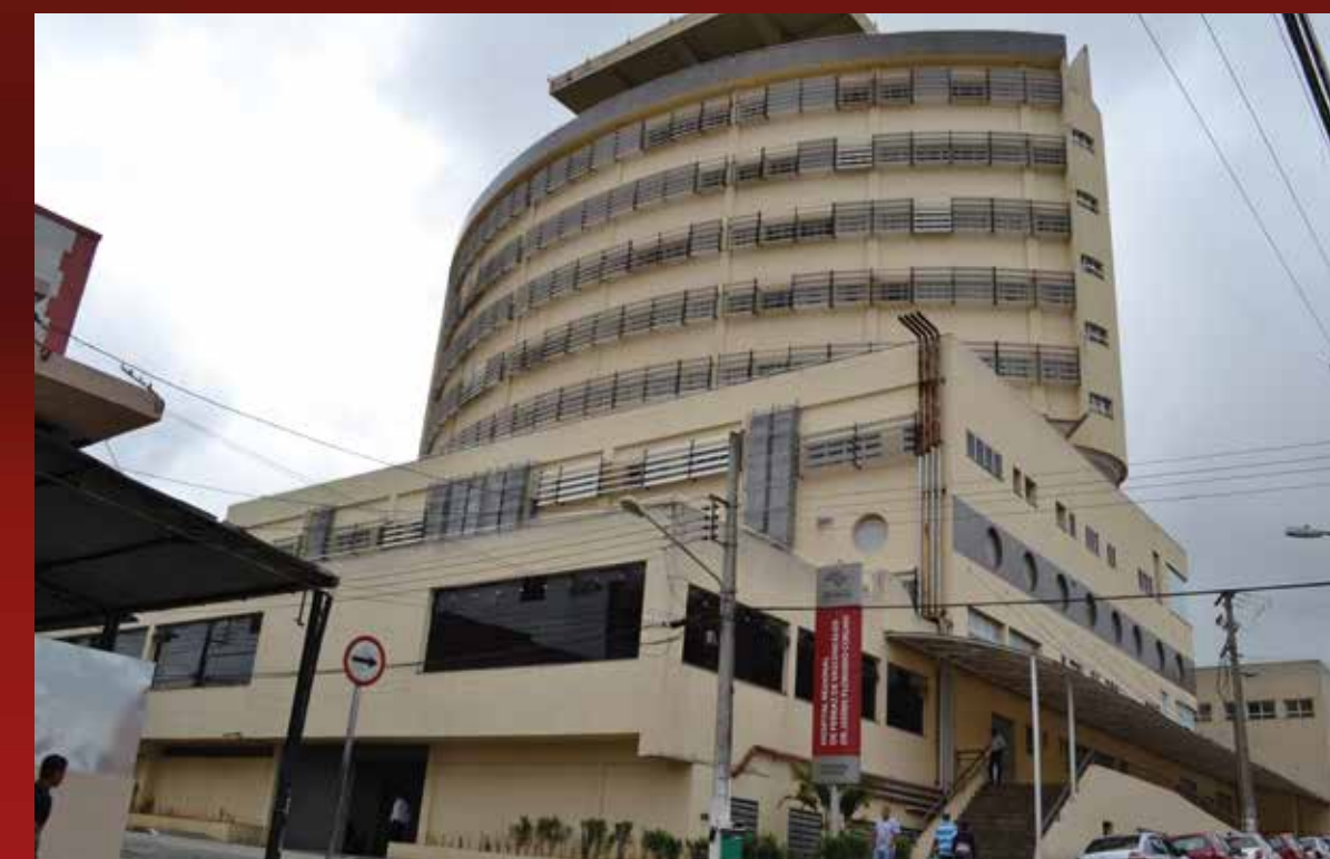
HOSPITAL REGIONAL DE FERRAZ DE VASCONCELOS
